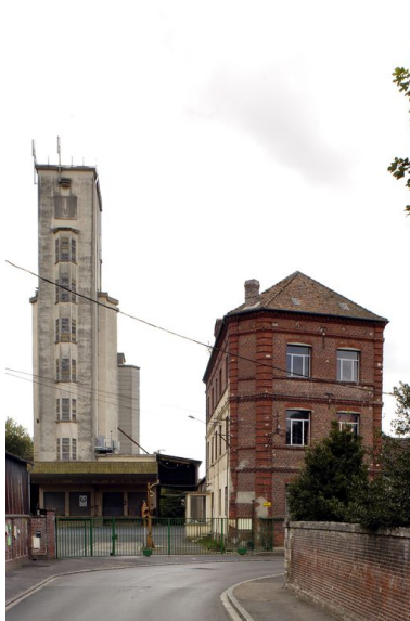
Vue générale depuis la rue de l'usine et des silos agricoles. Phot. Thierry Lefébure IVR22_20046000385NUCA
