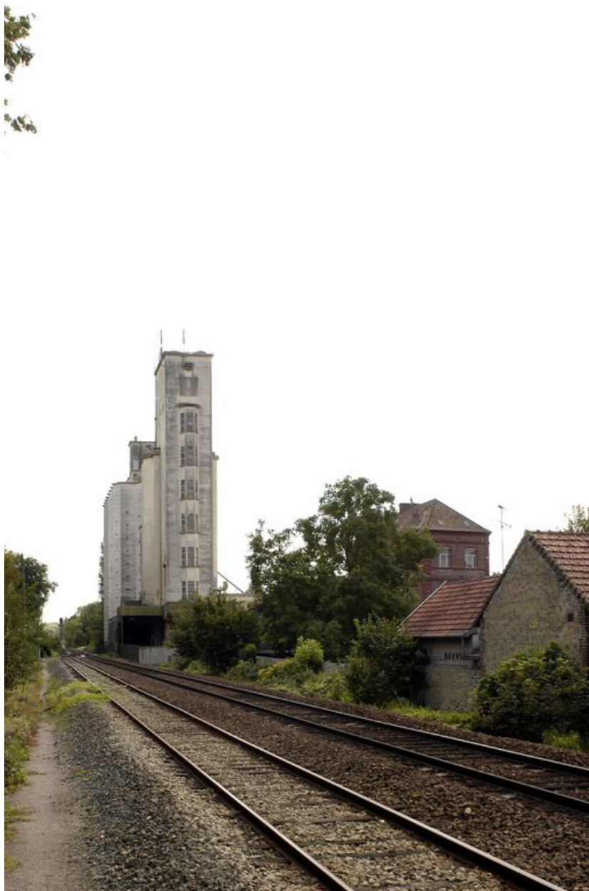
Vue d'ensemble des silos agricoles, depuis la voie de chemin de fer.
