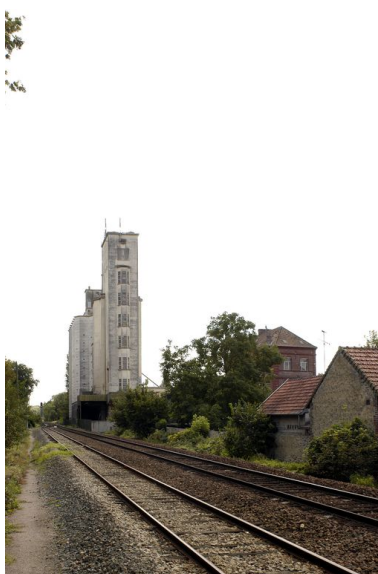
Vue d'ensemble des silos agricoles, depuis la voie de chemin de fer. Phot. Bertrand Fournier IVR22_20046003098NUCA
