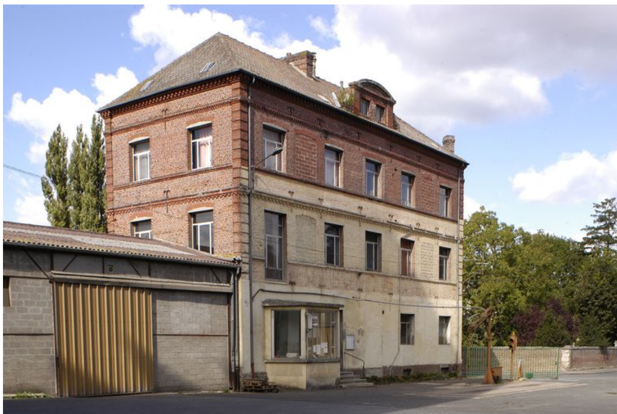
Façade sur cour de l'atelier de fabrication.
