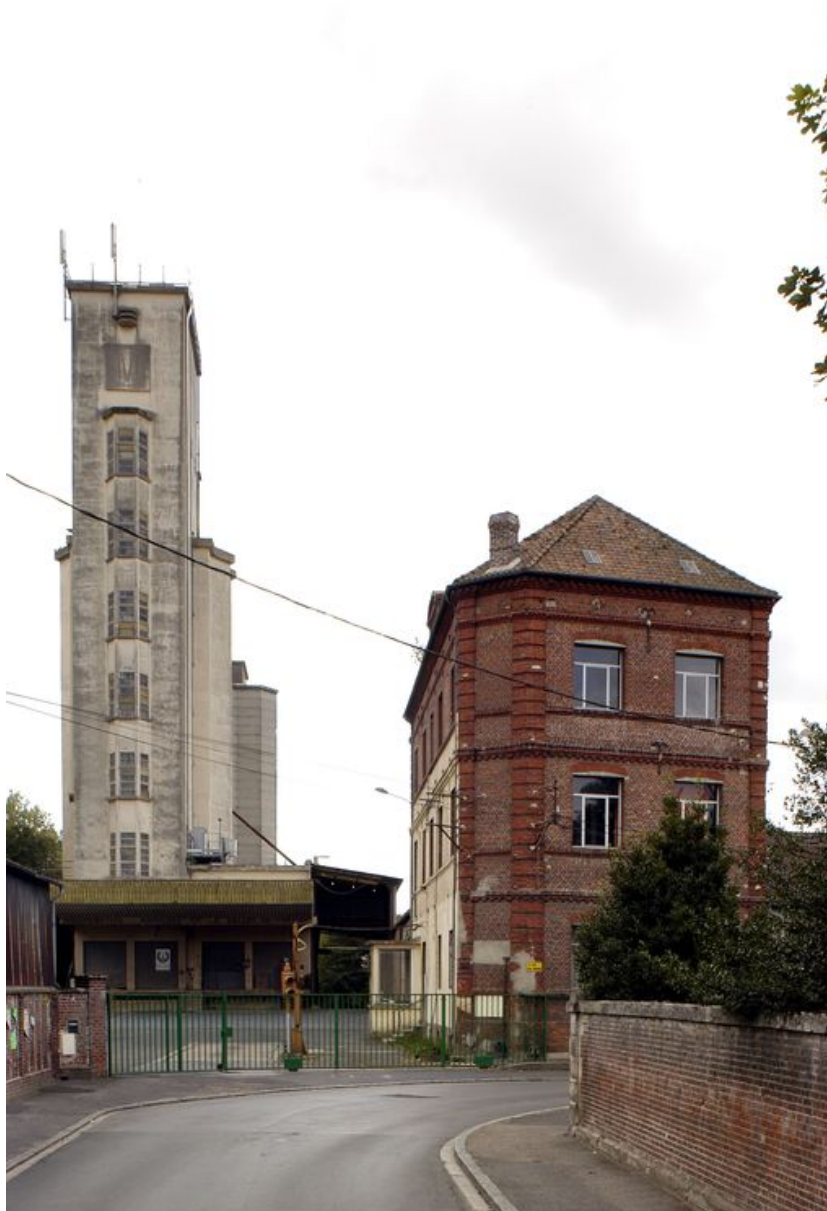
Vue générale depuis la rue de l'usine et des silos agricoles.
