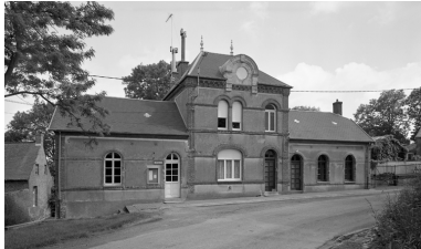
Vue générale. Phot. Thierry Lefébure IVR22_19910201003V
