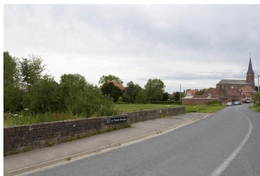
Le pont de la Peene Becque à Zuytpeene. Phot. Delphine Volto Jourdan IVR32_20245902662NUCA
