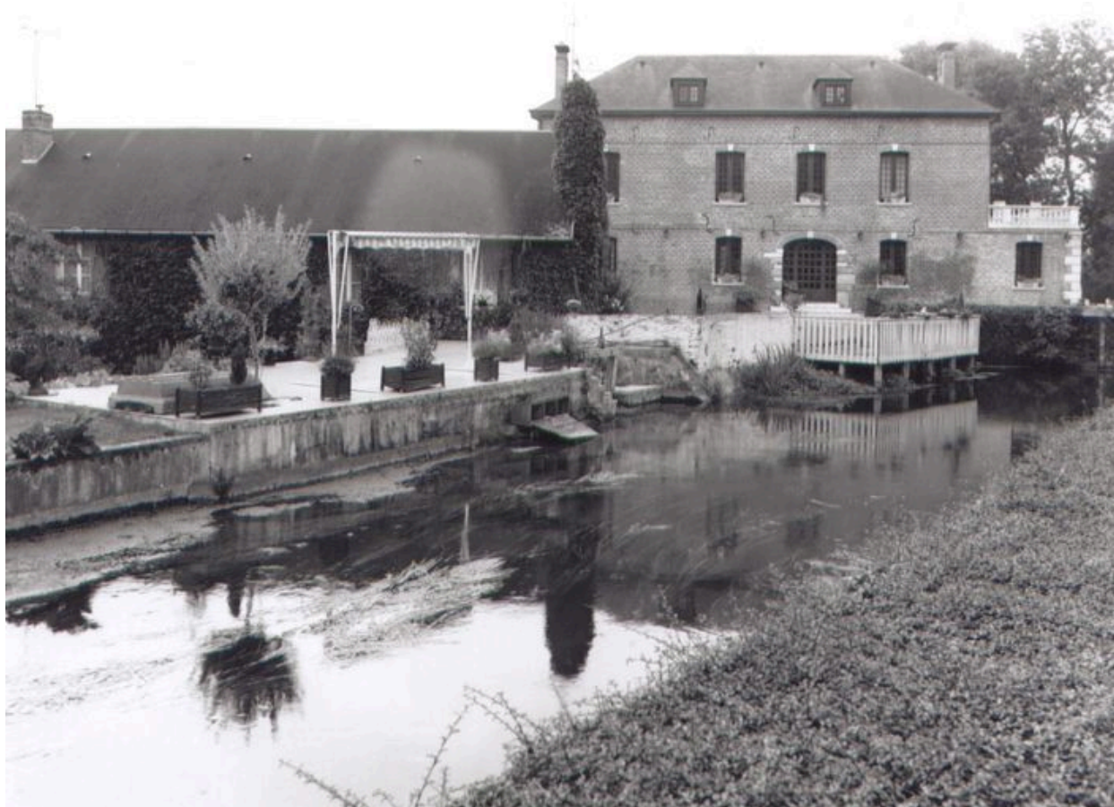
Vue d'ensemble du l'usine, côté ouest.
