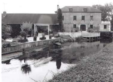
Vue d'ensemble de l'usine, côté ouest. Phot. Thierry Lefébure IVR22_20026000924X
