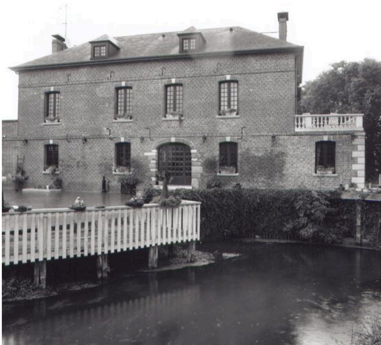
L'usine, façade ouest.
