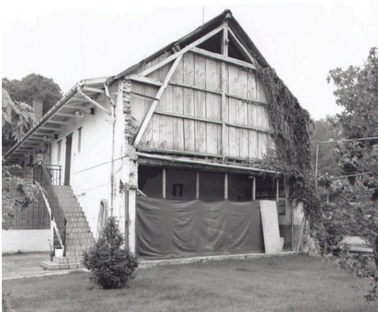
Ancienne dépendance agricole, convertie en logement.
