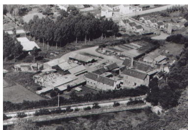
Vue aérienne de l'usine vers 1950 (coll. part.).
