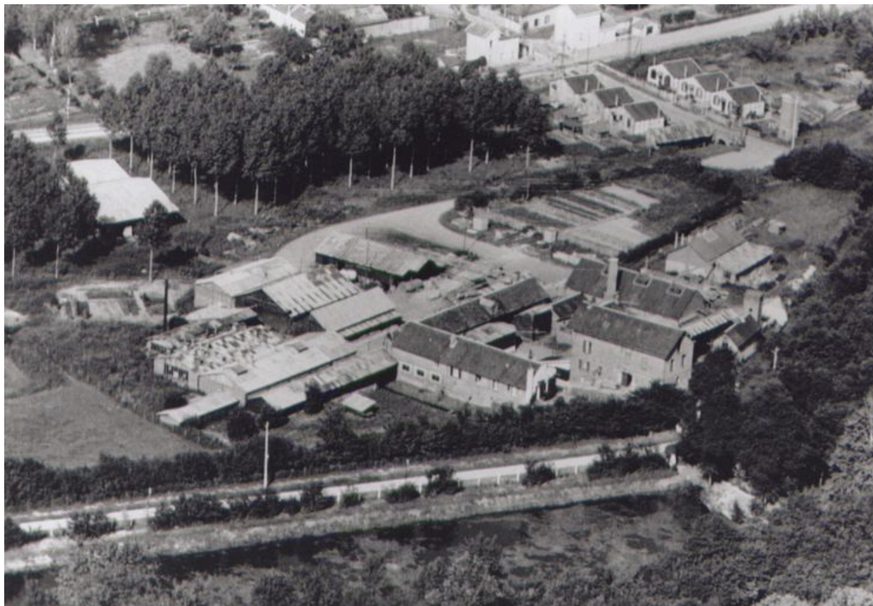
Vue aérienne de l'usine vers 1950 (coll. part.).
