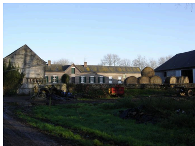
Vue générale sur la cour intérieure de la ferme. Phot. Catherine Fourmond IVR22_20048001047NUCA
