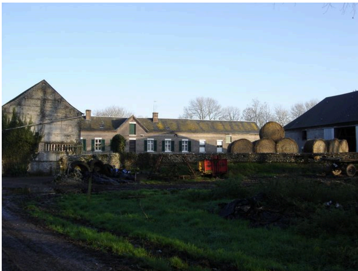
Vue générale sur la cour intérieure de la ferme.
