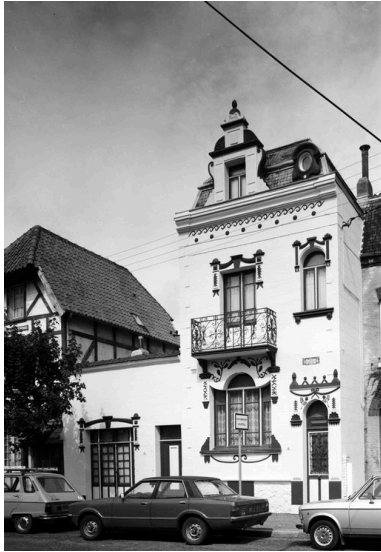
Vue générale en 1981. Phot. Eric Dessert IVR31_19816203692X
