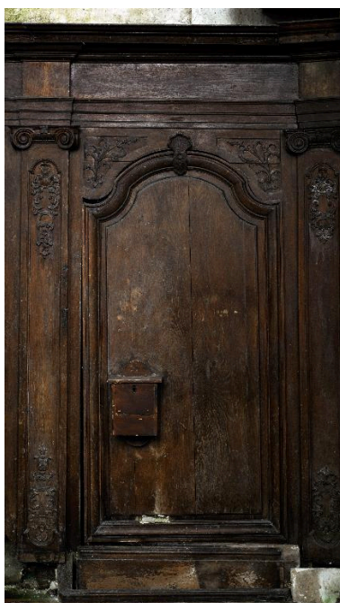
Panneau de lambris de l'abside, mur nord.
