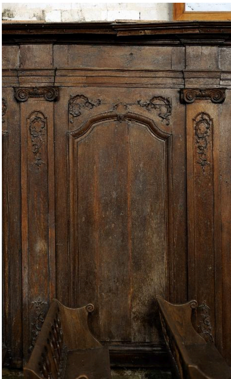
Panneau de lambris du chœur, mur nord.
