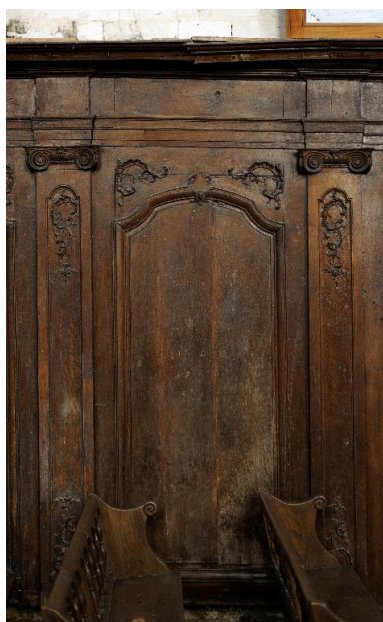
Panneau de lambris du chœur, mur nord.
