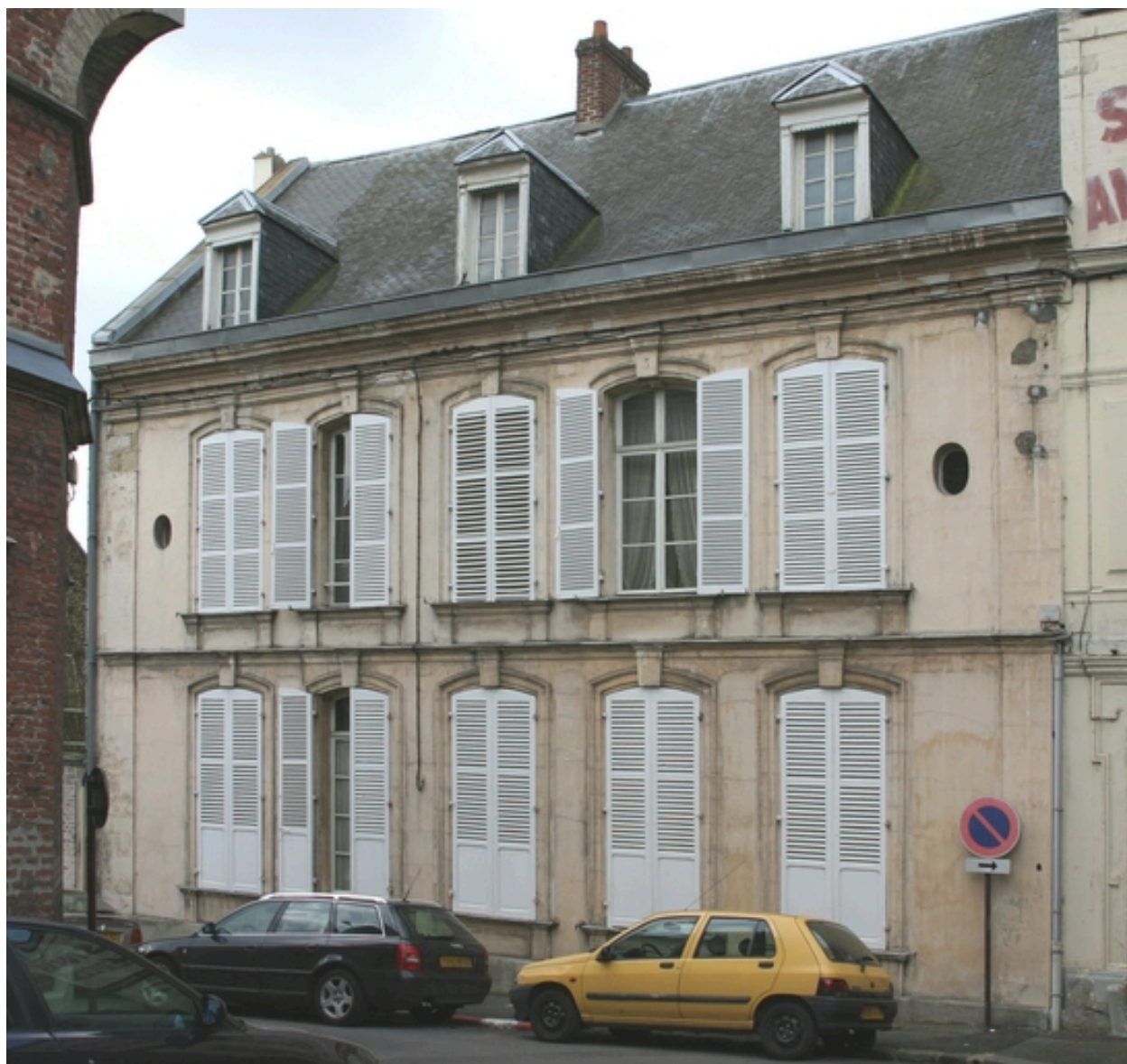
Façade antérieure du logement patronal.
