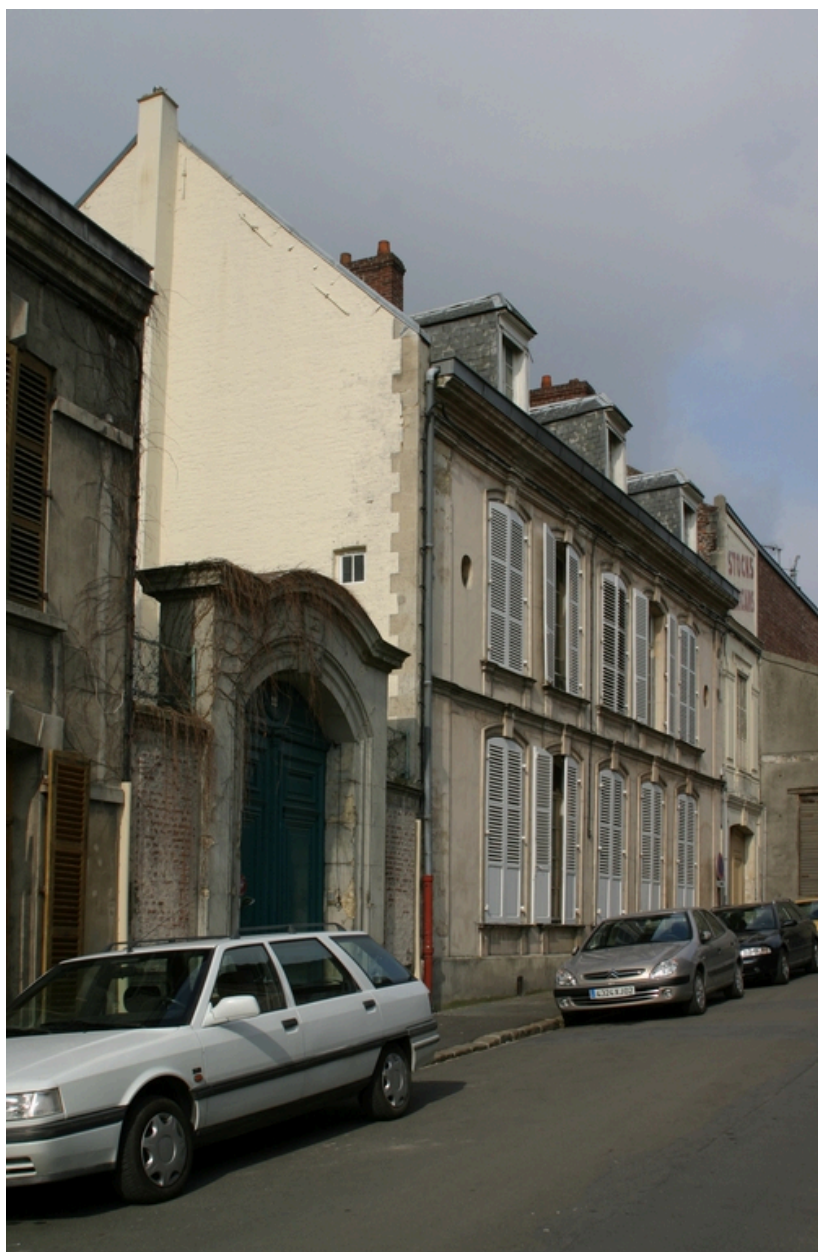
Façade antérieure du logement patronal.
