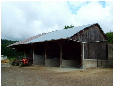
Vue du hangar. Phot. Inès Guérin IVR22_20030202202NUCA
