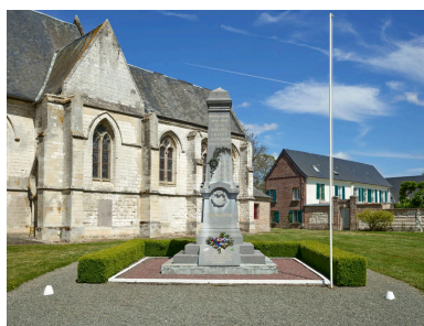
Vue générale depuis le sud-ouest. Phot. Thierry Lefébure IVR22_20228000108NUCA
