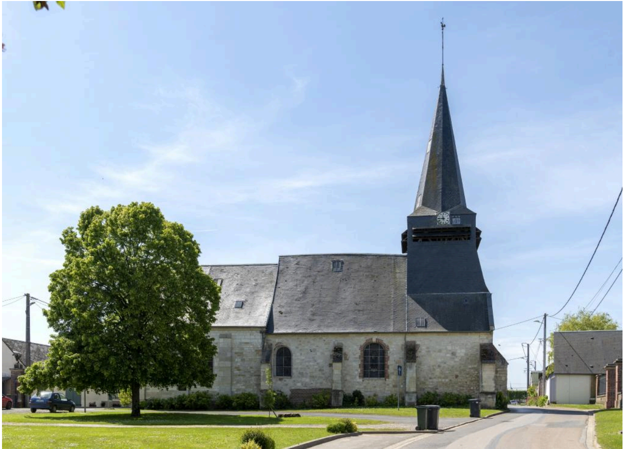
Vue depuis le nord.
