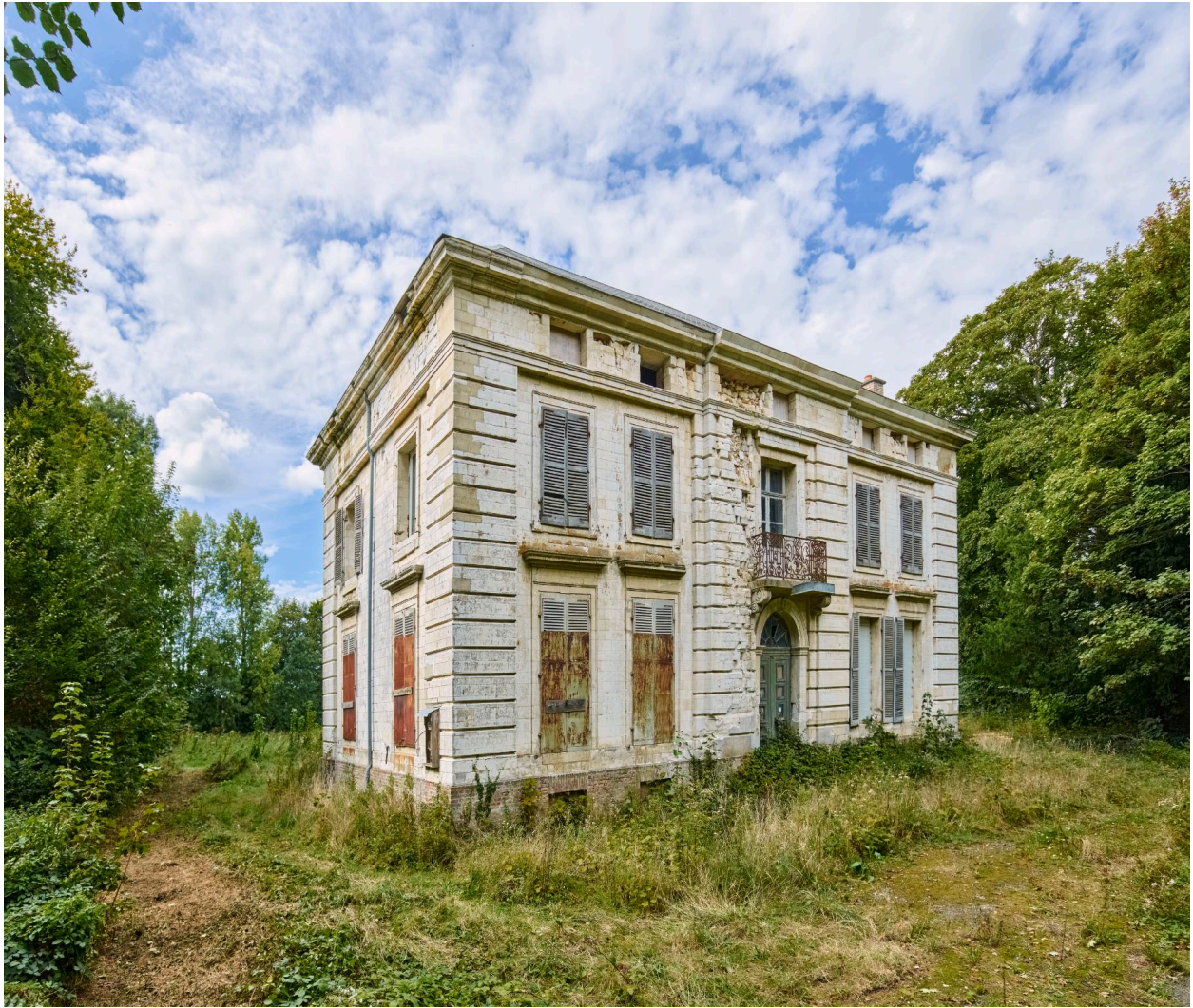
Vue de trois quarts depuis la cour.
