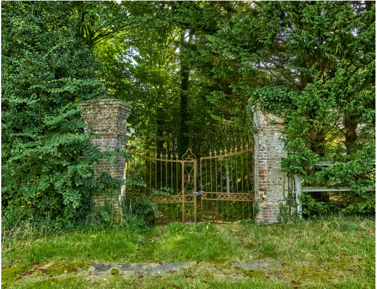
Grille d'entrée de la ferme attenante au château de Faveilles dit Château Blanc.
