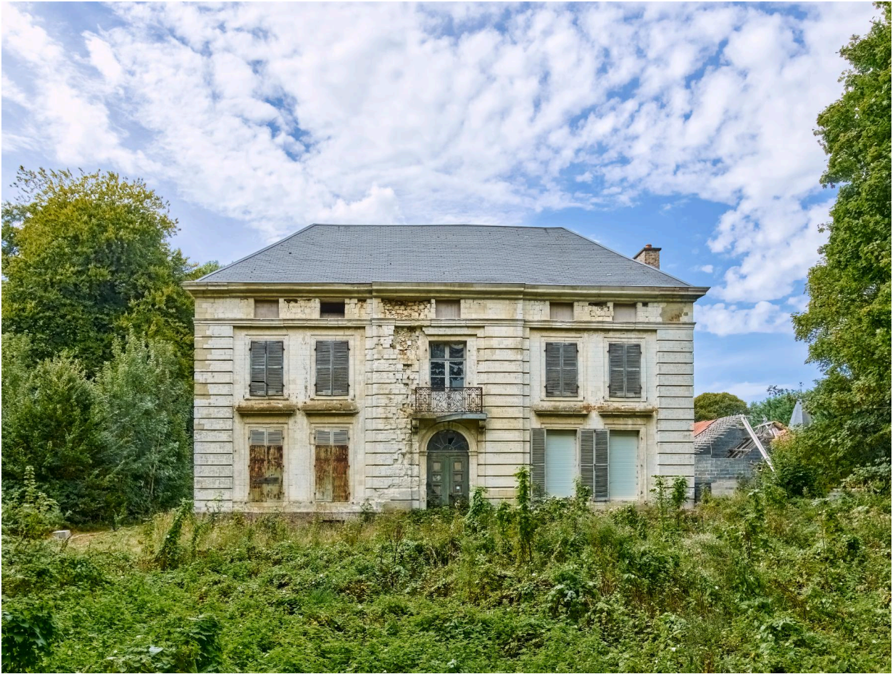
Façade principale sur cour.
