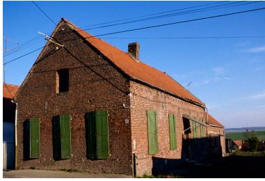
Vue d'ensemble nord-ouest de l'édifice daté de 1890. Phot. Christiane Riboulleau IVR22_19900203025ZA
