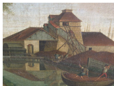
Détail : fabrique. Phot. Anita Oger-Leurent IVR31_20055906014NUCA
