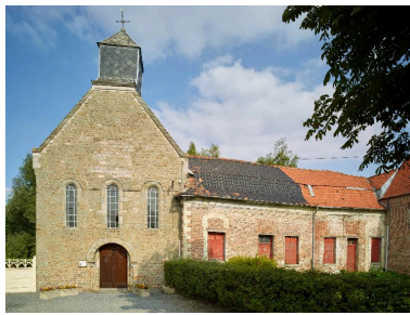
Vue générale de la chapelle et du prieuré attenant. Phot. Pierre Thibaut IVR31_20155901602NUCA
