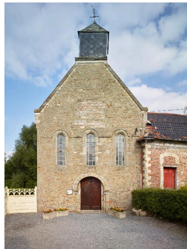
Elévation antérieure de la chapelle. Phot. Pierre Thibaut IVR31_20155901601NUCA
