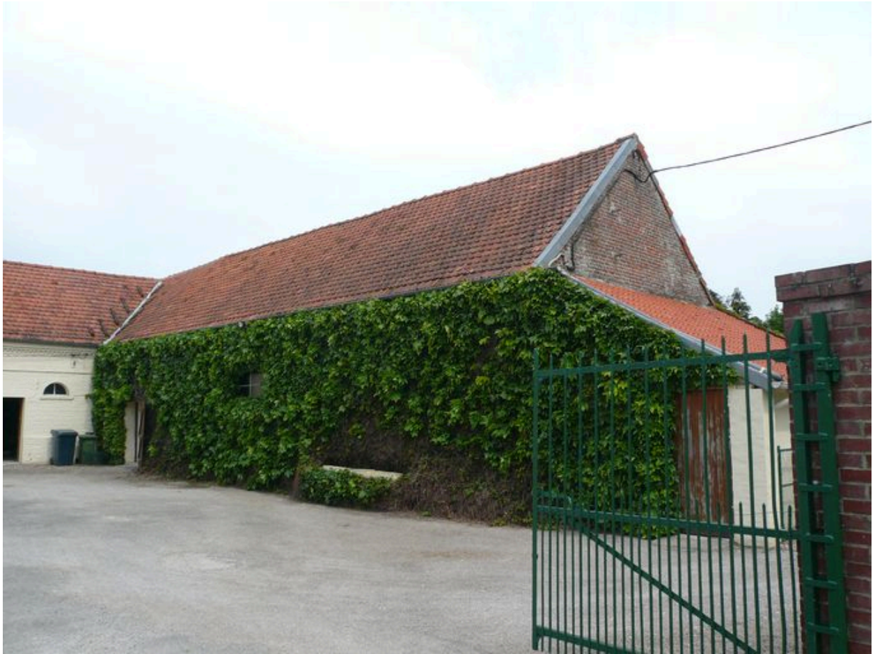
Vue de la grange.
