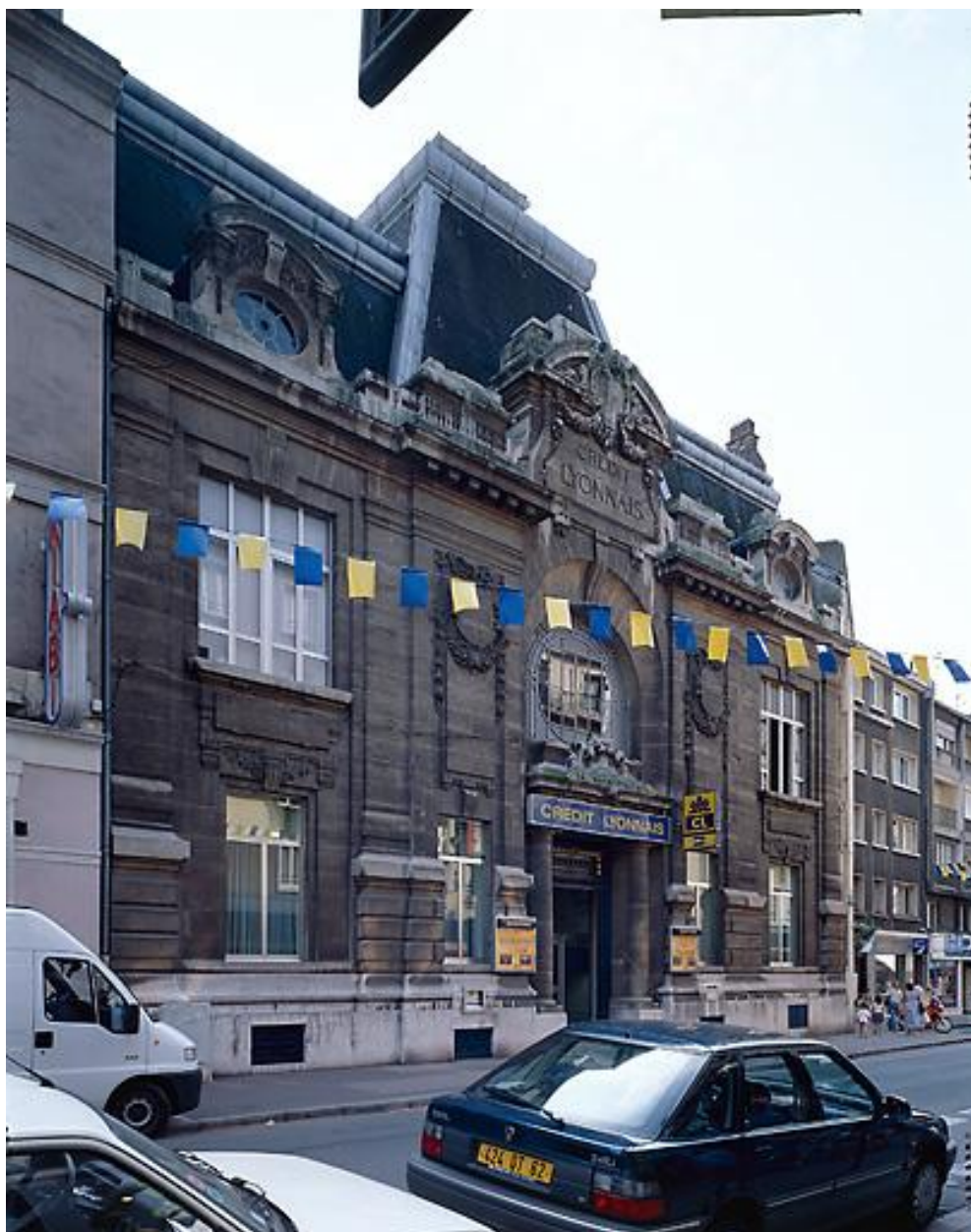
Vue générale sur voie.
