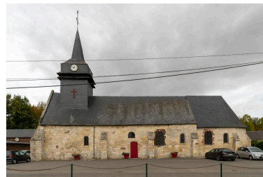
Vue depuis le sud. Phot. Marc Kérignard IVR32_20216000946NUCA
