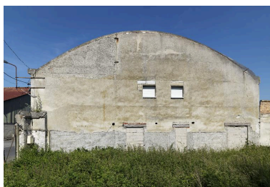
Pignon est de l'atelier principal de la conserverie. Phot. Thierry Lefébure IVR22_20158000259NUC2A
