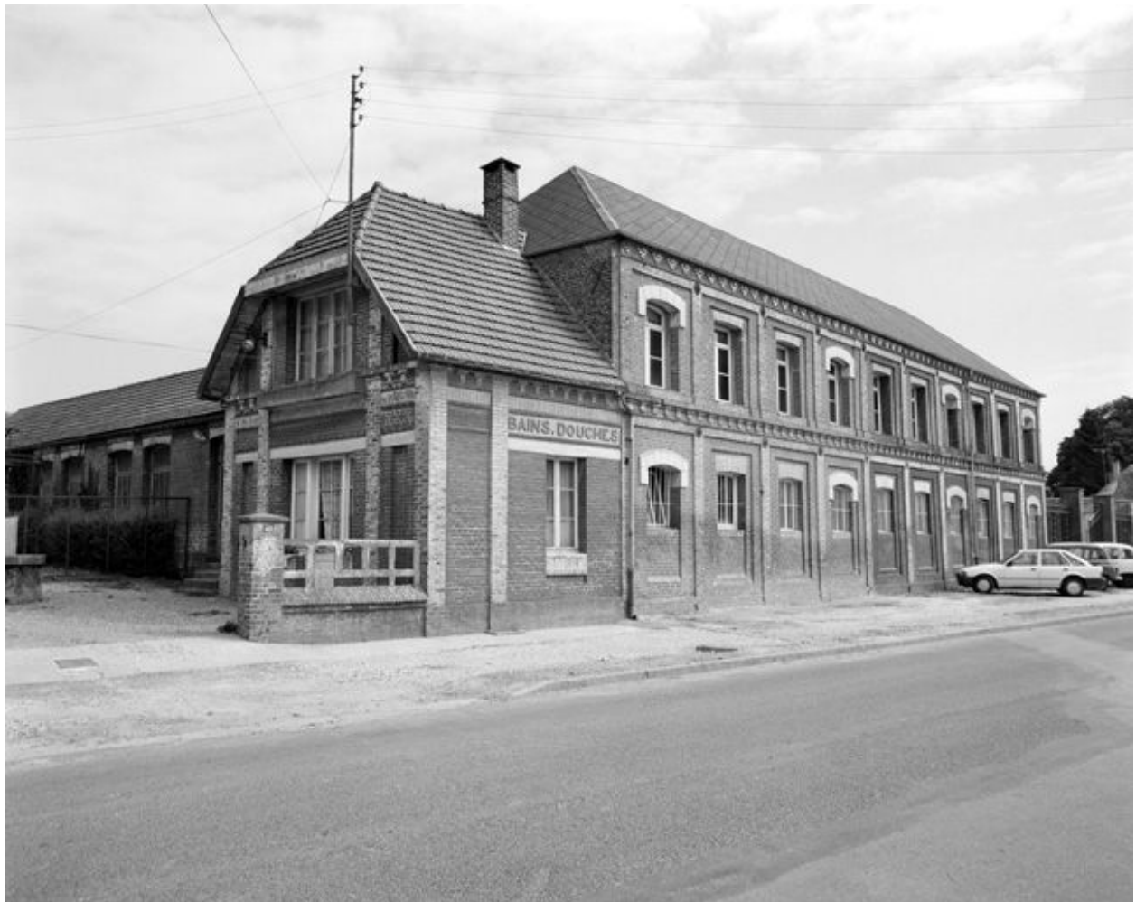
Bureau et atelier de fabrication, élévation antérieure.
