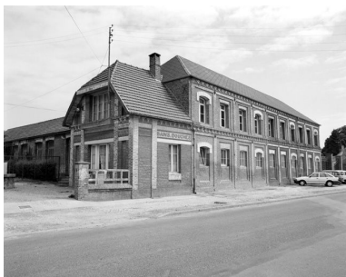
Bureau et atelier de fabrication, élévation antérieure.
