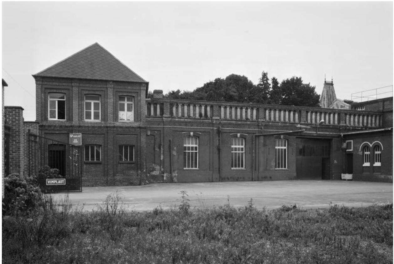
Atelier de fabrication et bureau, flanc est.
