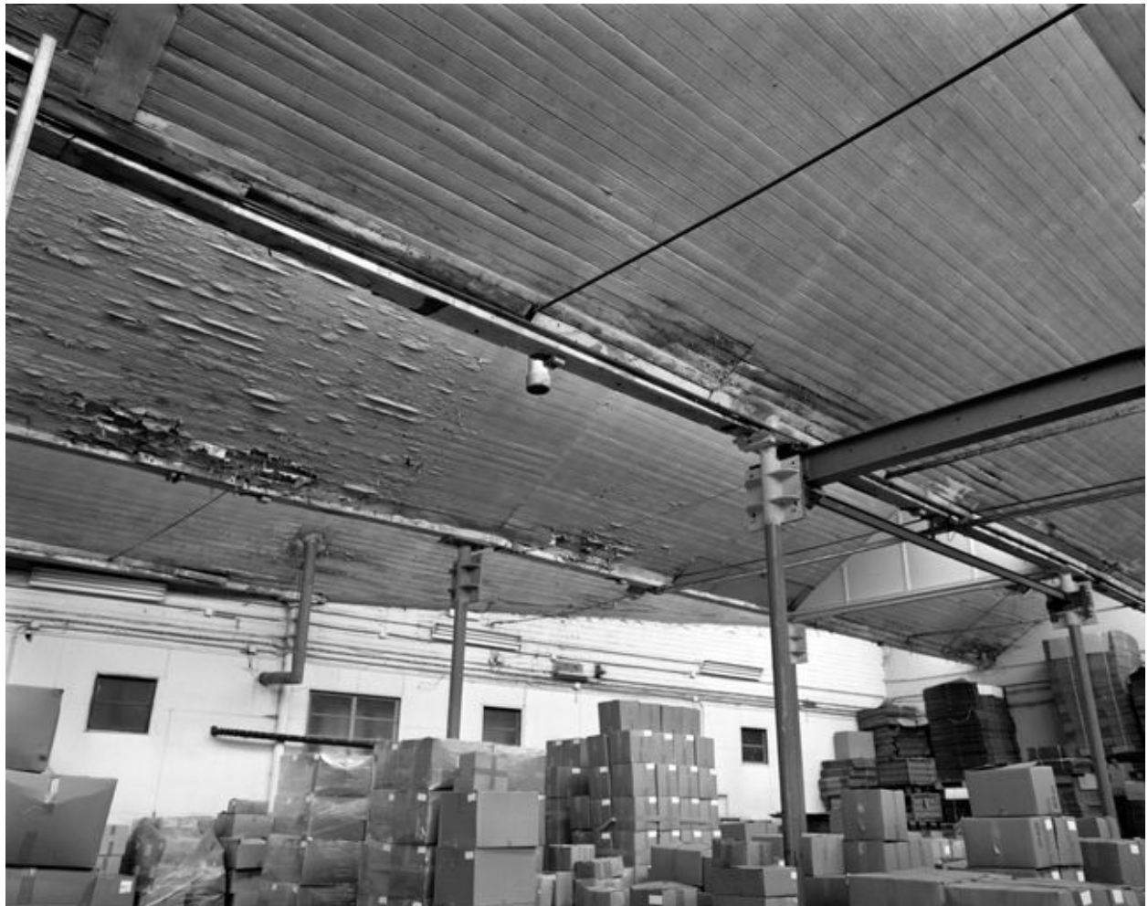
Atelier de fabrication, vue inférieure.
