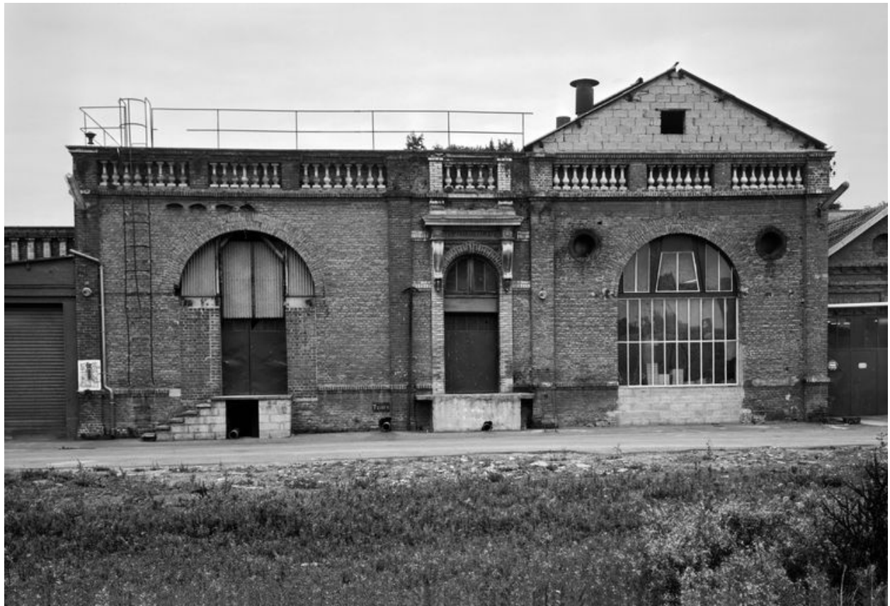
Chaufferie et salle des machines, flanc est.
