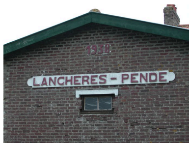
Détail porté sur le bâtiment principal de la gare de Lanchères. Phot. Elisabeth Justome IVR22_20038005436NUCA
