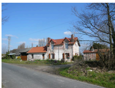
L'ancienne gare de Ponthoile-Romaine. Phot. Inès Guérin IVR22_20078005579NUCA
