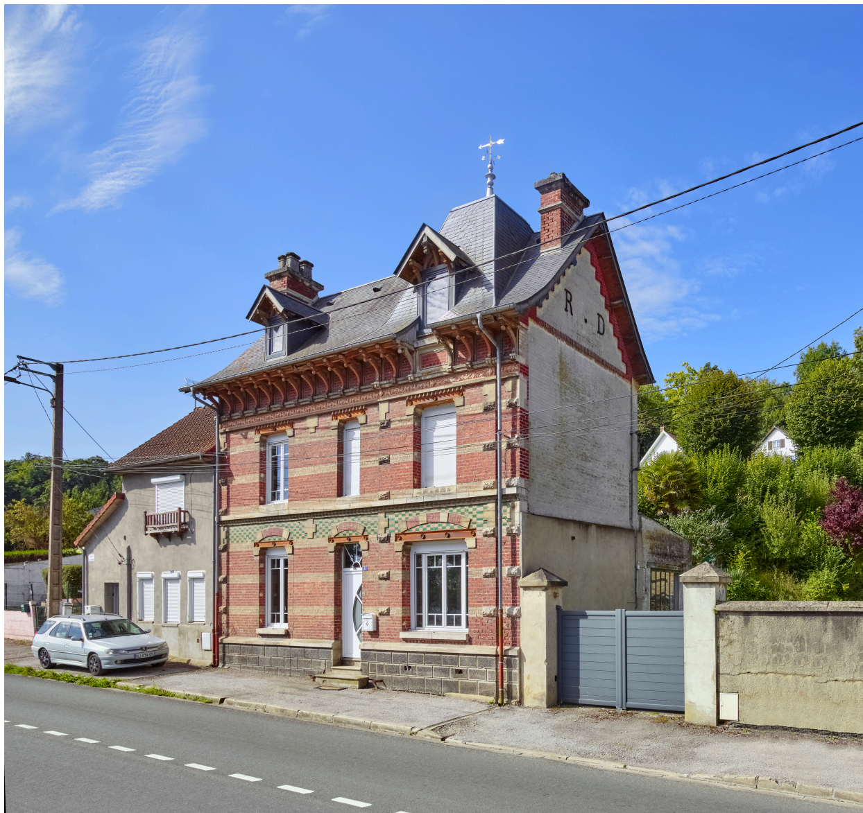
Vue de la maison depuis le nord-est.
