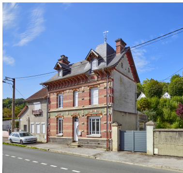
Vue de la maison depuis le nord-est.
