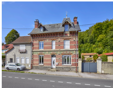
Vue de la maison depuis l'est.
