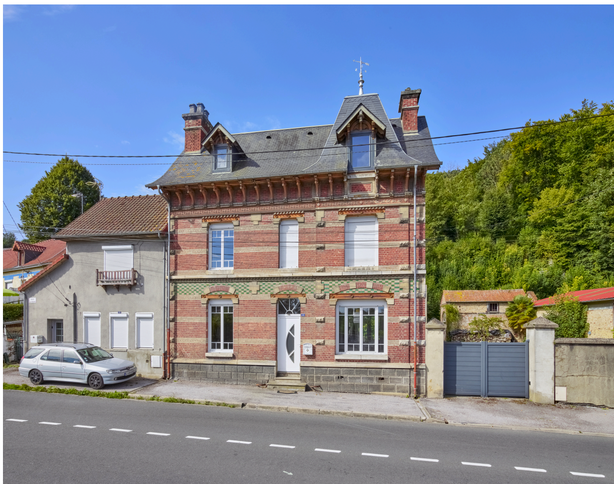
Vue de la maison depuis l'est.
