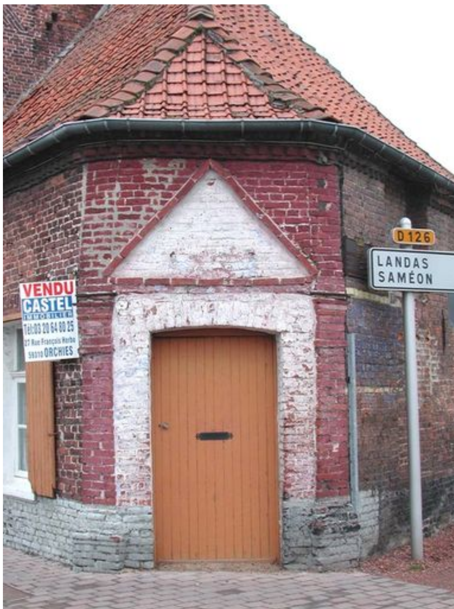
Détail de la travée d'angle.
