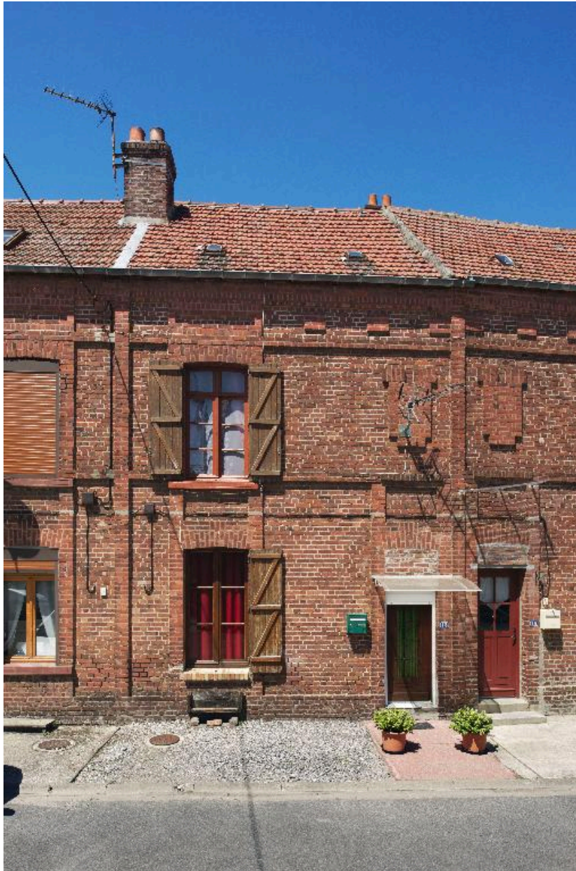
Détail du logement n°13 de l'impasse Gabriel-Péri.
