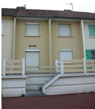
Détail d'une unité, façade antérieure. Phot. Elisabeth Justome IVR22_20058003265NUCA
