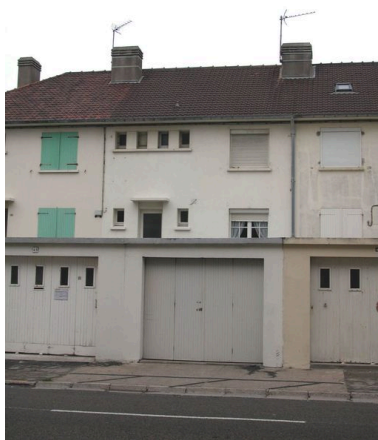
Détail d'une unité, façade postérieure. Phot. Elisabeth Justome IVR22_20058003267NUCA
