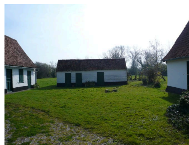
Vue des porcheries à l'est de la cour. Phot. Inès Guérin IVR22_20078005754NUCA
