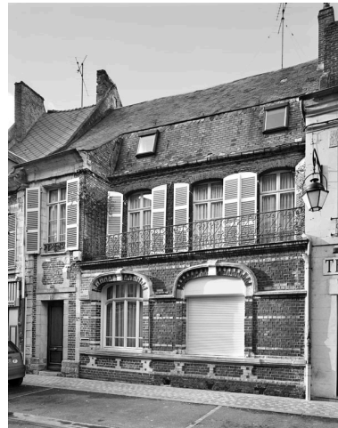
Vue de la façade sur rue. Phot. Thierry Lefébure IVR22_20020201155X
