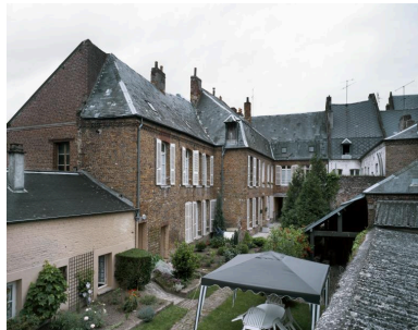
Vue des façades sur cour. Phot. Thierry Lefébure IVR22_19990202681VA
