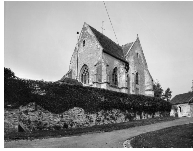
Vue du chevet et de la chapelle sud. Phot. Thierry Lefébure IVR22_19890200894V
