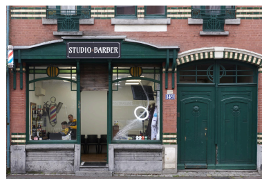
Détail des porche, coffret et vitrine du rez-de-chaussée. Phot. Delphine Volto Jourdan IVR32_20265900111NUCA
