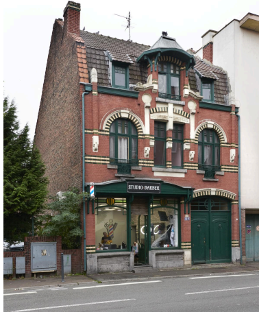
Vue générale de trois quarts avec pignon. Phot. Delphine Volto Jourdan IVR32_20265900109NUCA
