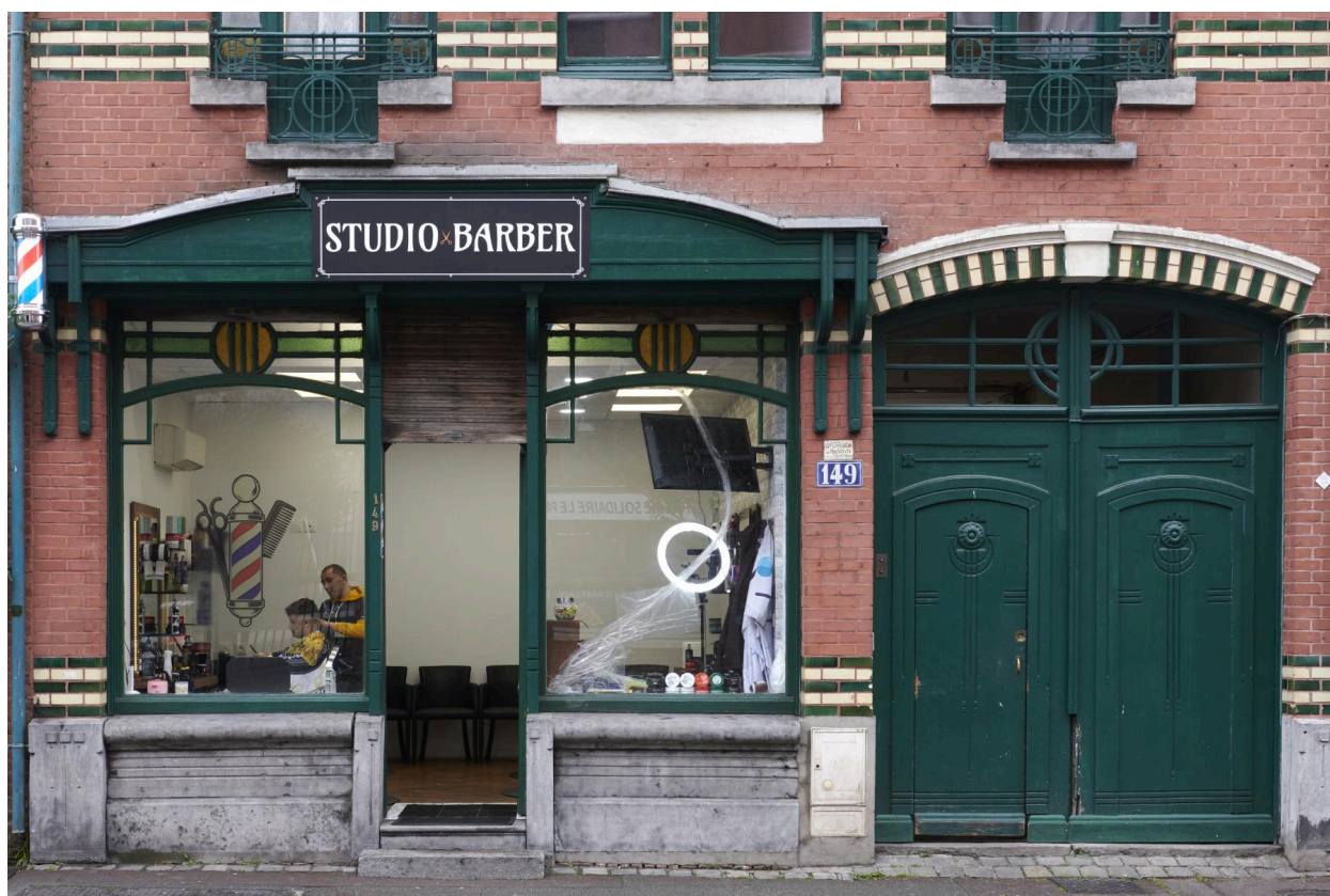
Détail des porche, coffret et vitrine du rez-de-chaussée.
