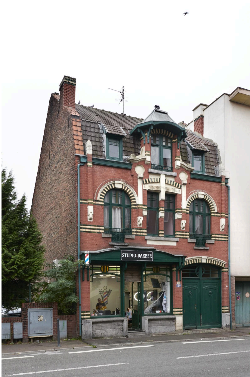
Vue générale de trois quarts avec pignon.
