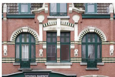
Détail de l'encadrement des fenêtres et des baies. Phot. Delphine Volto Jourdan IVR32_20265900113NUCA
