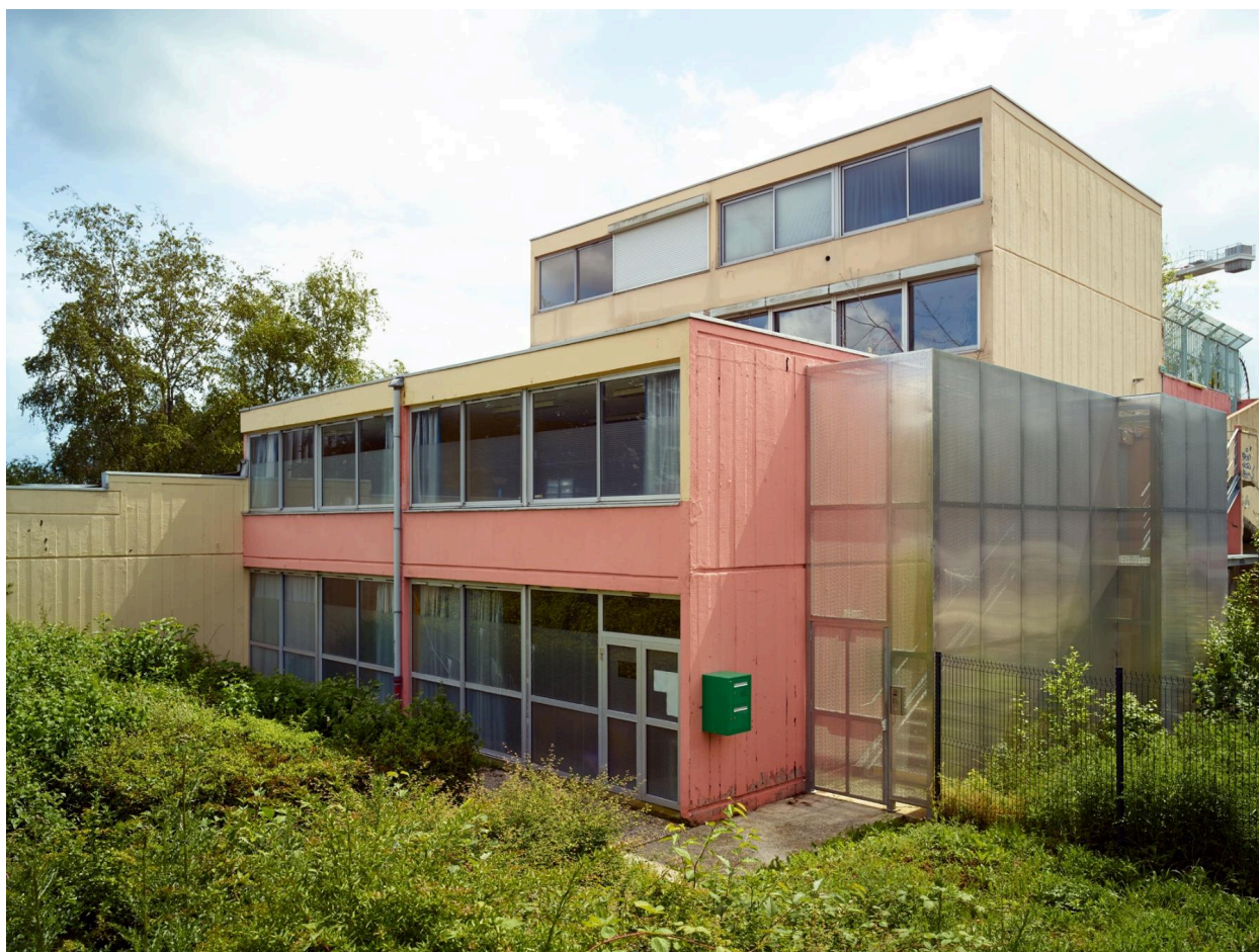
Vue de la façade nord-ouest du groupe scolaire et du patio, depuis la passerelle du chemin des Visiteurs, au sud-ouest.
