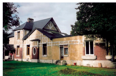
Façade postérieure. Phot. Gilles-Henri Bailly IVR22_20158005603NUCA
