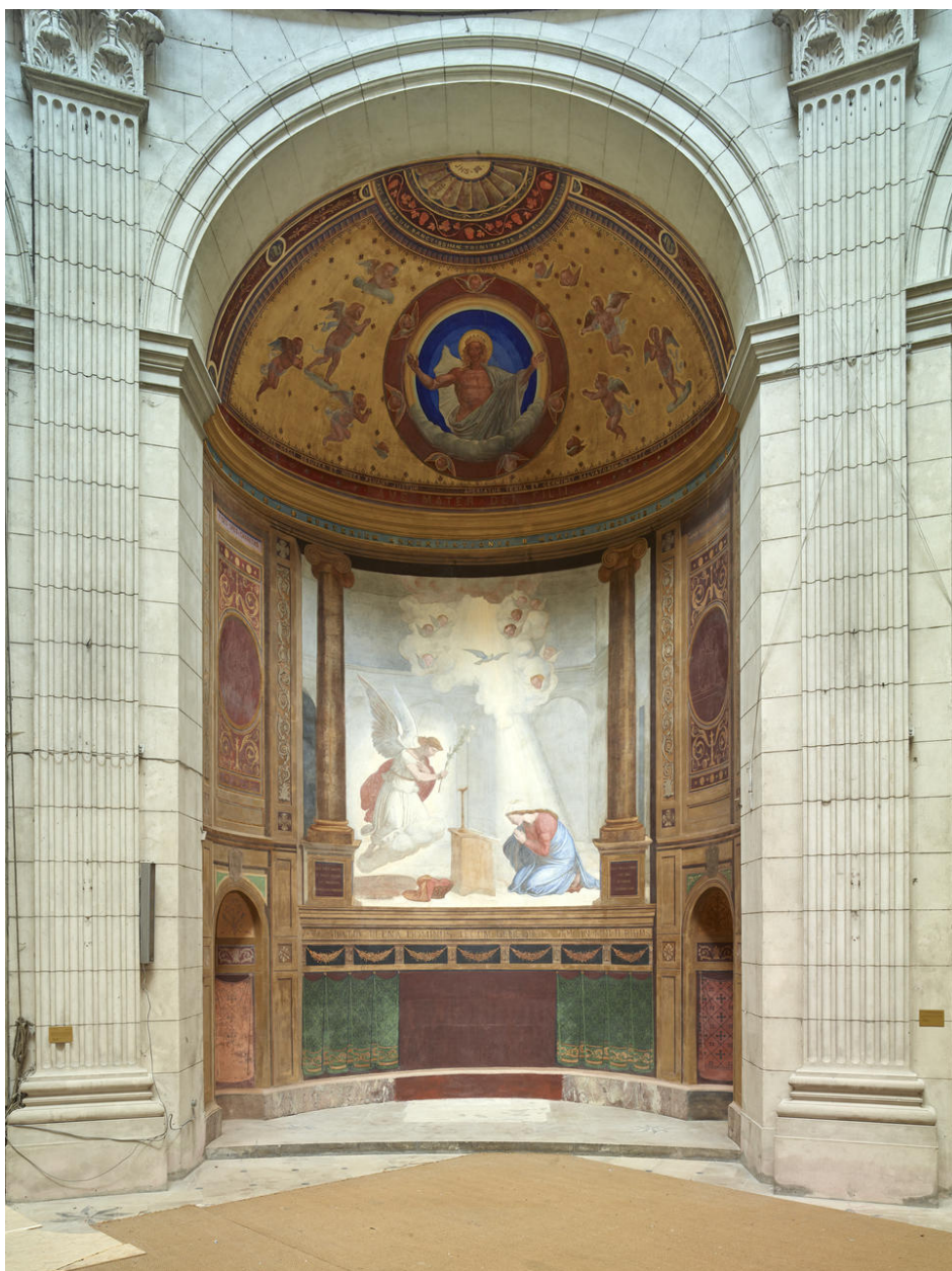
Vue générale, après restauration.
