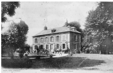
Etat avant 1914 (AP). Phot. Jean-Michel Périn IVR22_19856000193XB
