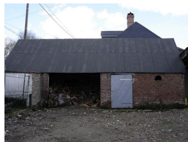
Vue d'une étable en retour d'équerre à l'est du logis. Phot. Inès Guérin IVR22_20058005266NUCA
