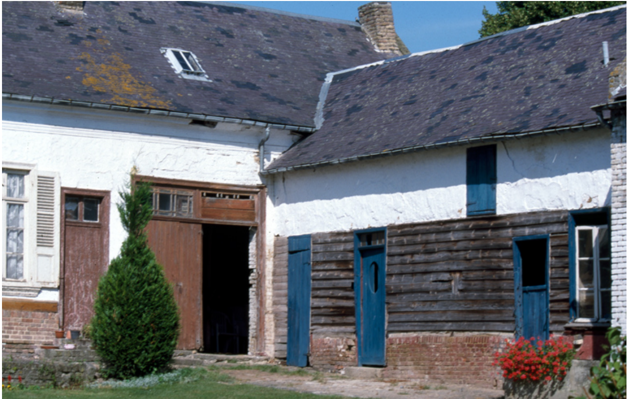
Vue des écuries au nord.
