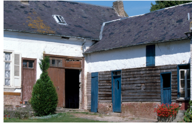
Vue des écuries au nord. Phot. Irwin Leullier IVR22_19998001603ZA
