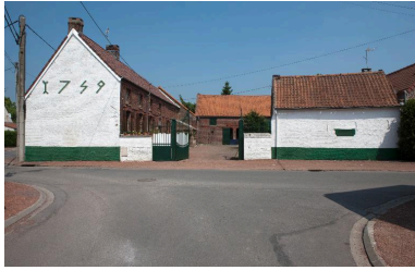
Vue générale d'une ferme à cour fermée, 34 rue Basse. Phot. Pierre Thibaut IVR31_20125901773NUCA
