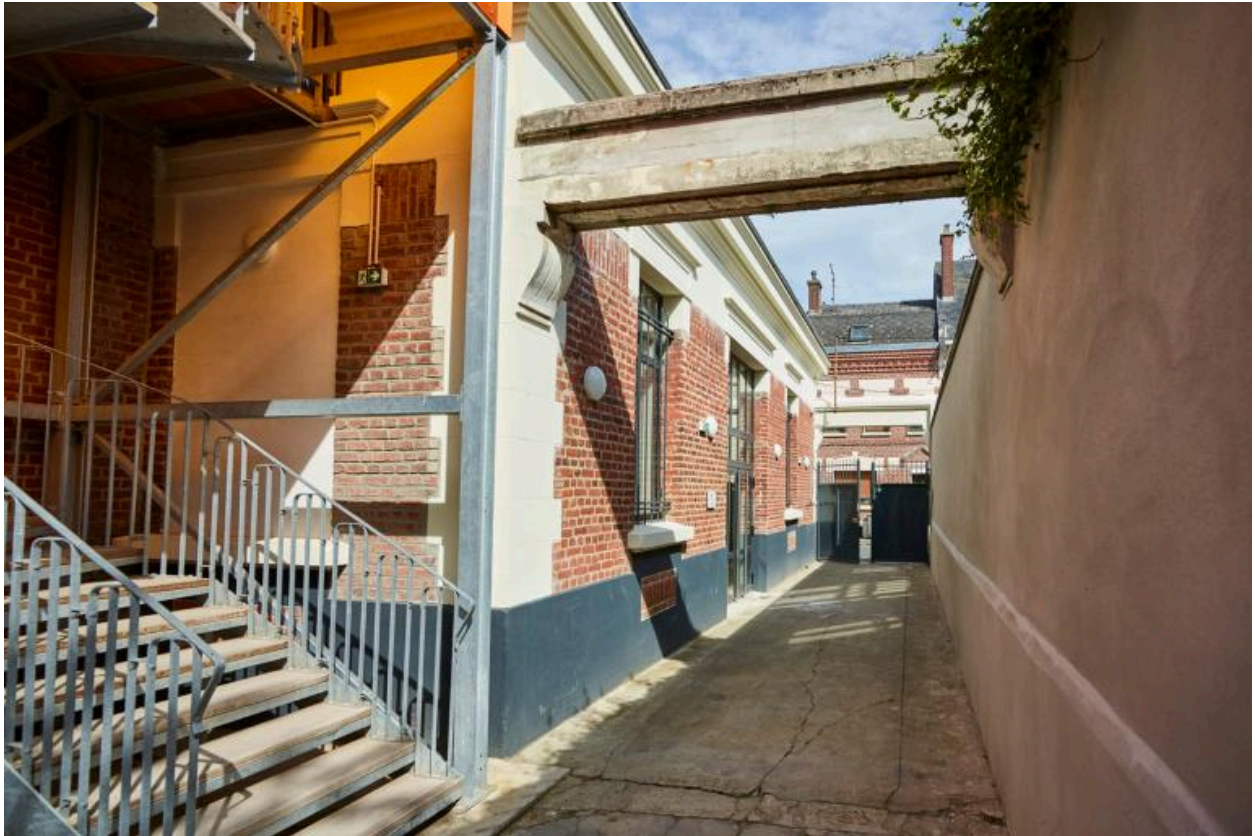
Le passage latéral donnant accès à l'arrière de l'ancien bureau de poste.
