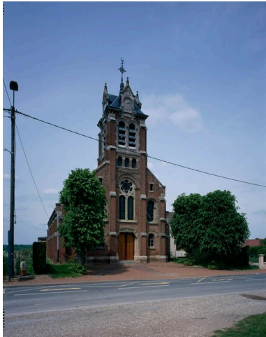
Vue générale. Phot. Thierry Lefébure IVR22_20038000472VA
