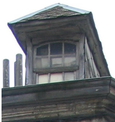
Façade, pan coupé, détail : lucarne. Phot. François Bismar IVR31_20065906125NUCA
