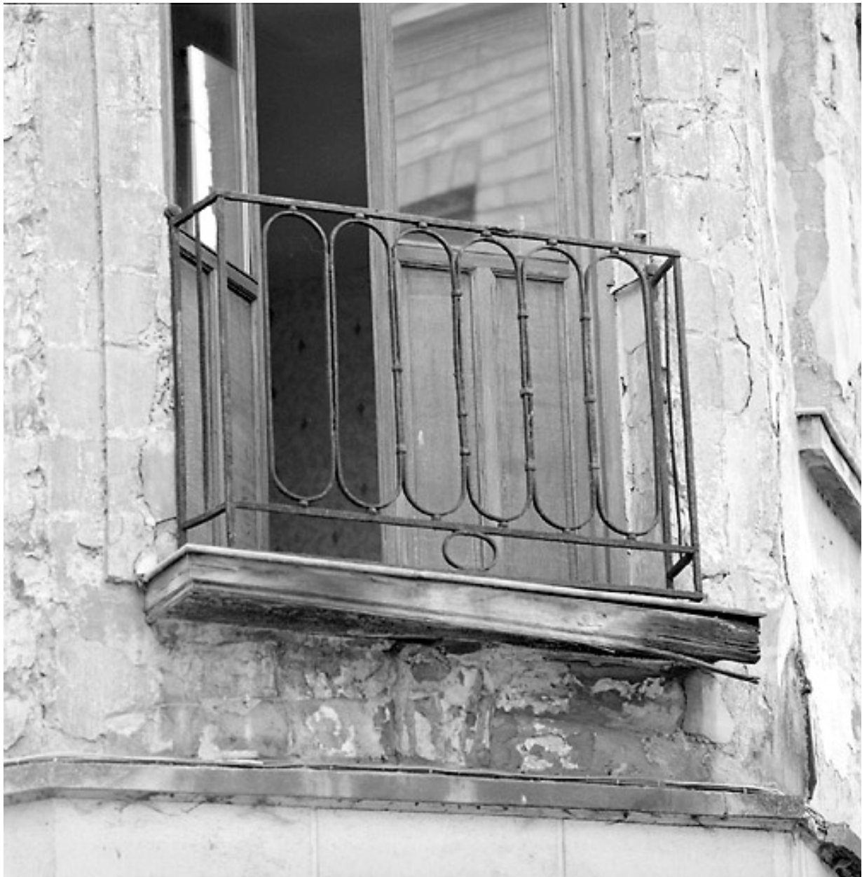
Façade, pan coupé, détail : garde-corps du balconnet.
