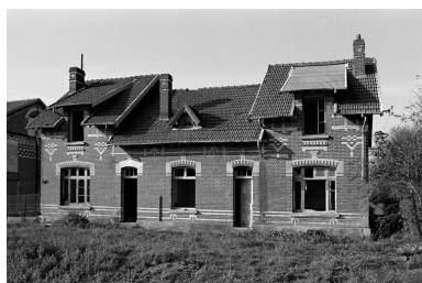
Logement de contremaître. Phot. Francis Dubuc IVR22_19908001247Z
