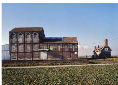
Vue d'ensemble de la râperie. Phot. Thierry Lefébure IVR22_20058002432XA
