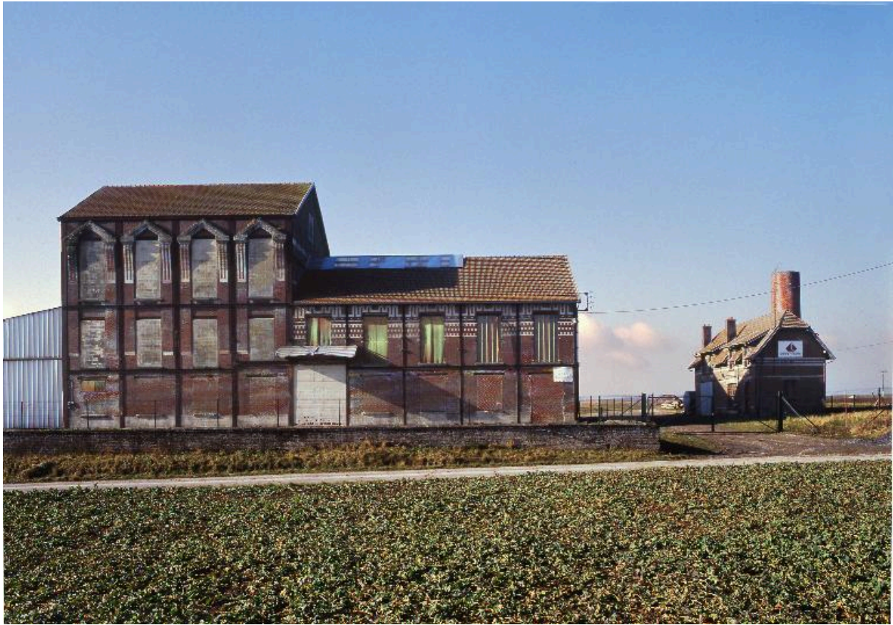
Vue d'ensemble de la râperie.
