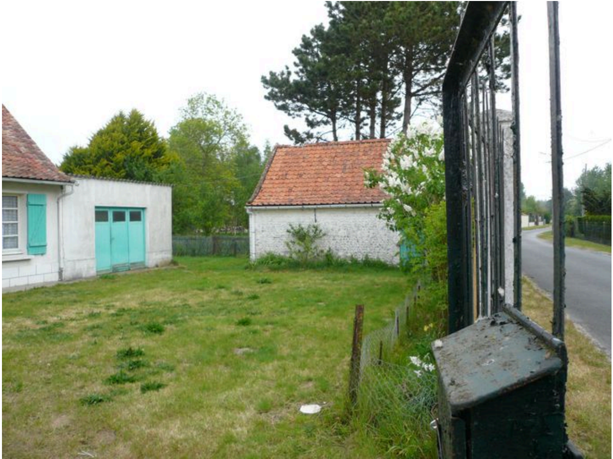
Vue du bâtiment annexe.
