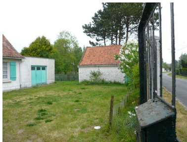
Vue du bâtiment annexe. Phot. Inès Guérin IVR22_20078005804NUCA
