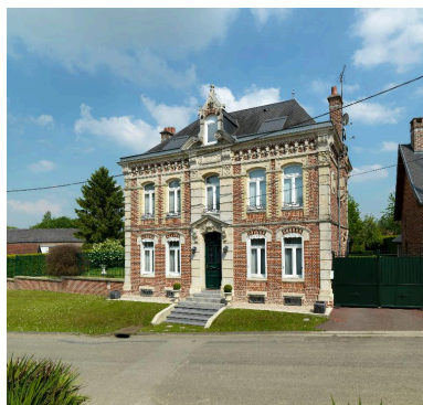
Vue d'ensemble sur rue. Phot. Thierry Lefébure IVR22_20138000221NUC2AQ
