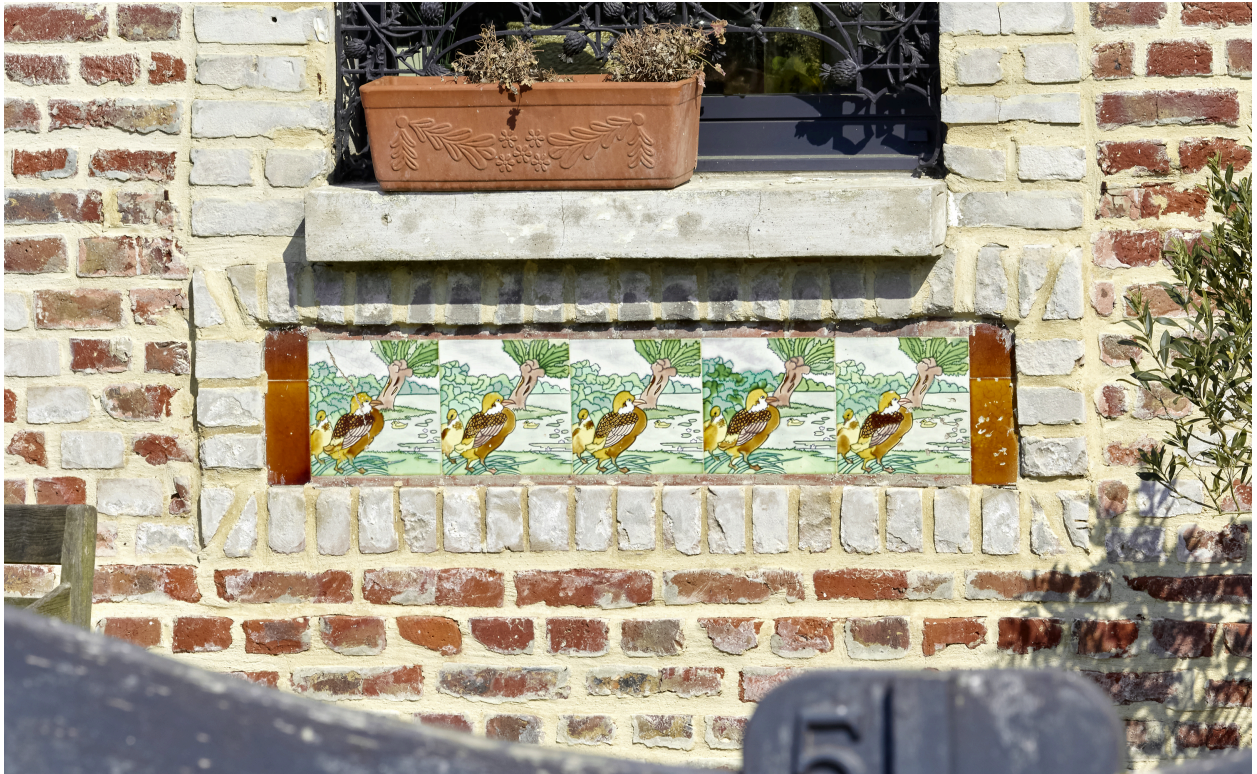
Détail des carreaux de céramique sous l'appui des fenêtres.
