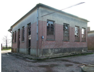
Vue d'ensemble nord-est. Phot. Bertrand Fournier IVR22_20056000654NUCA
