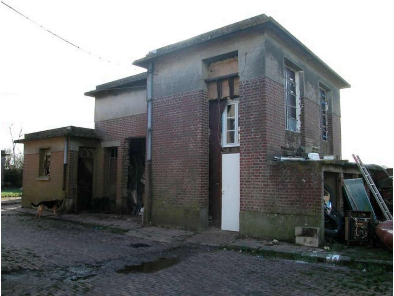
Bâtiment de stockage des viandes.
