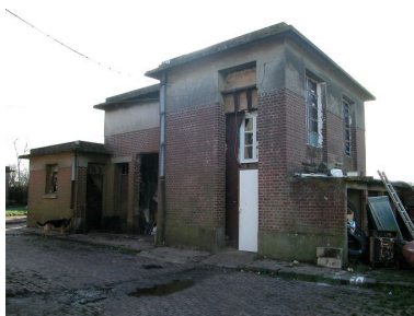
Bâtiment de stockage des viandes. Phot. Bertrand Fournier
