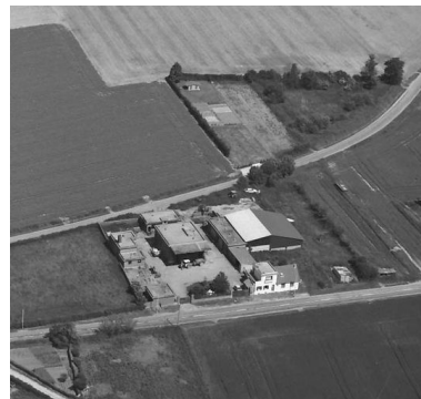
Vue aérienne de l'abattoir en 1994. Phot. Sanson Aviation IVR22_19946001675X
