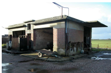
Abri à voitures. Phot. Bertrand Fournier IVR22_20056000657NUCA
