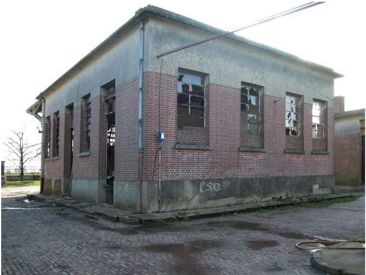
Vue d'ensemble nord-est.
