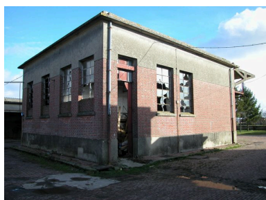
Vue d'ensemble nord-ouest. Phot. Bertrand Fournier IVR22_20056000656NUCA
