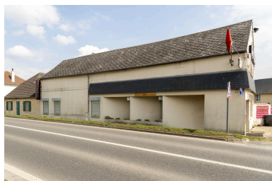
Café-restaurant, vue depuis l'ouest. Phot. Marc Kérignard IVR32_20216000306NUCA
