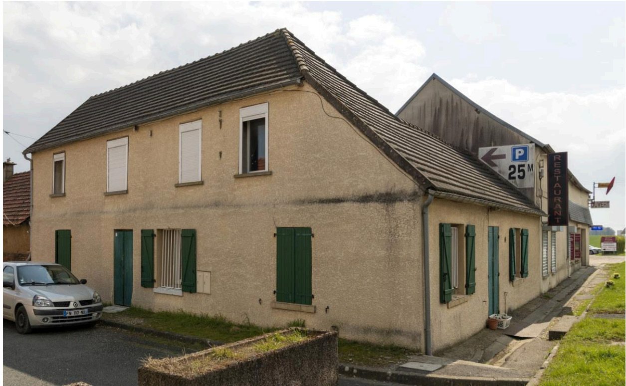
Logis sur la parcelle de l'ancienne auberge, vue depuis le nord.
