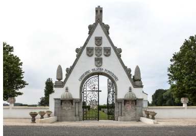
Vue du portail d'entrée. Phot. Jean-Marc Ramette IVR32_20166200391NUCA
