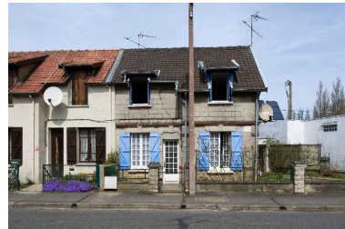
Détails d'une unité d'habitation. Phot. Thierry Lefébure IVR22_20138000137NUC2A
