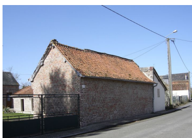
Vue postérieure des étables à vaches. Phot. Inès Guérin IVR22_20058005472NUCA
