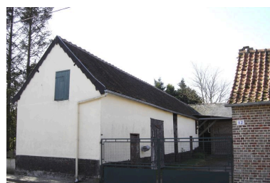
Vue de la grange. Phot. Inès Guérin IVR22_20058005473NUCA
