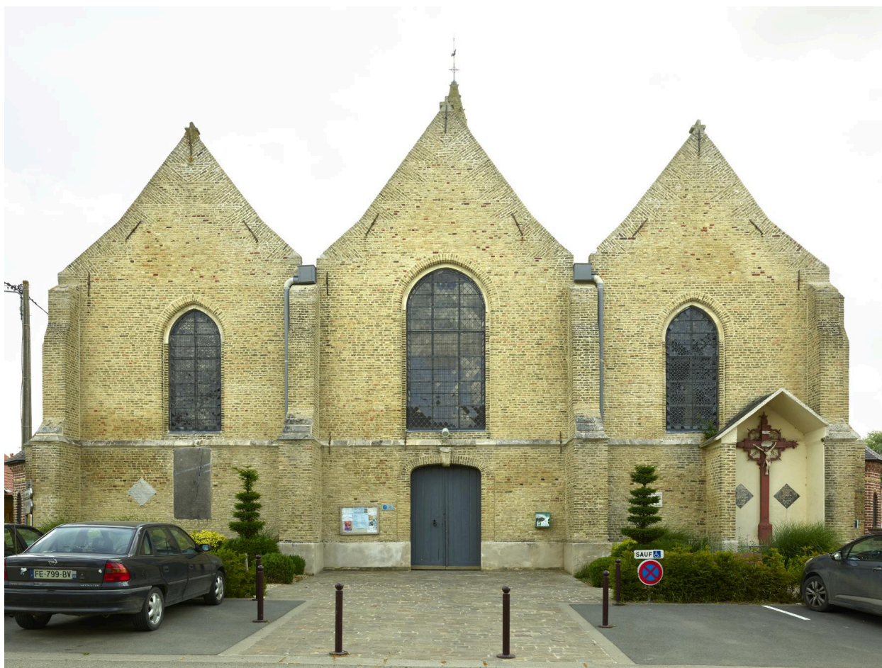
Vue générale de la façade occidentale.
