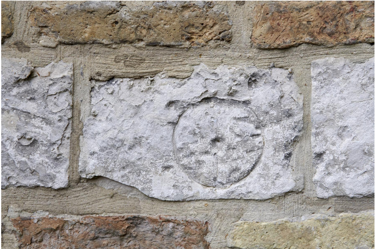
Gravure en forme de cercle, centre pointé. Base de la façade orientale.
