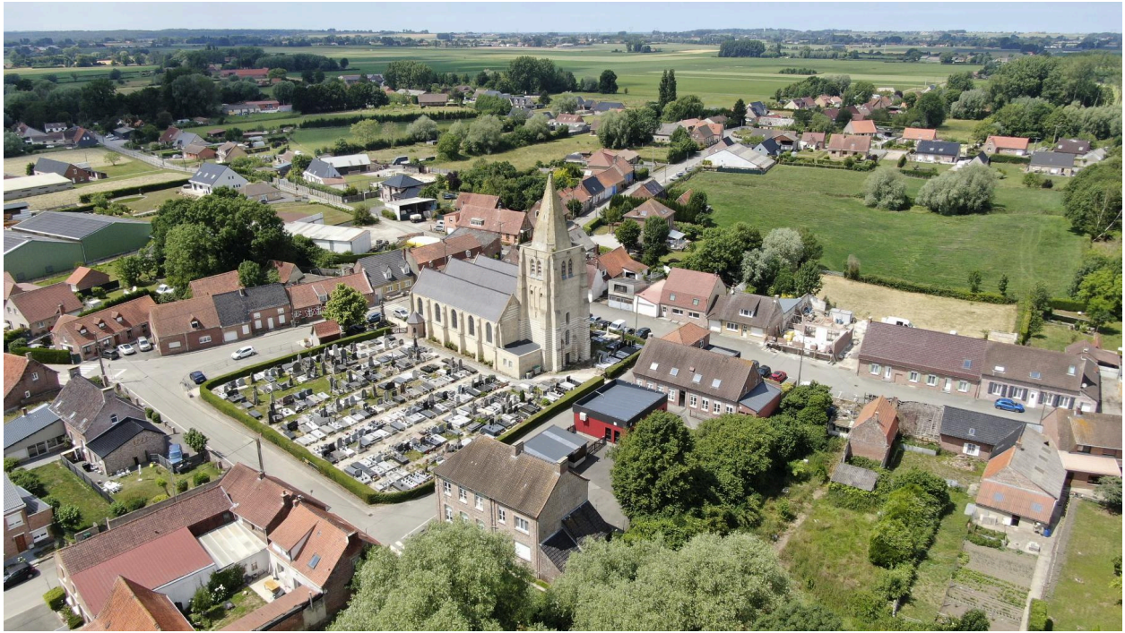
Vue aérienne de l'église prise depuis le sud-est de l'édifice.
