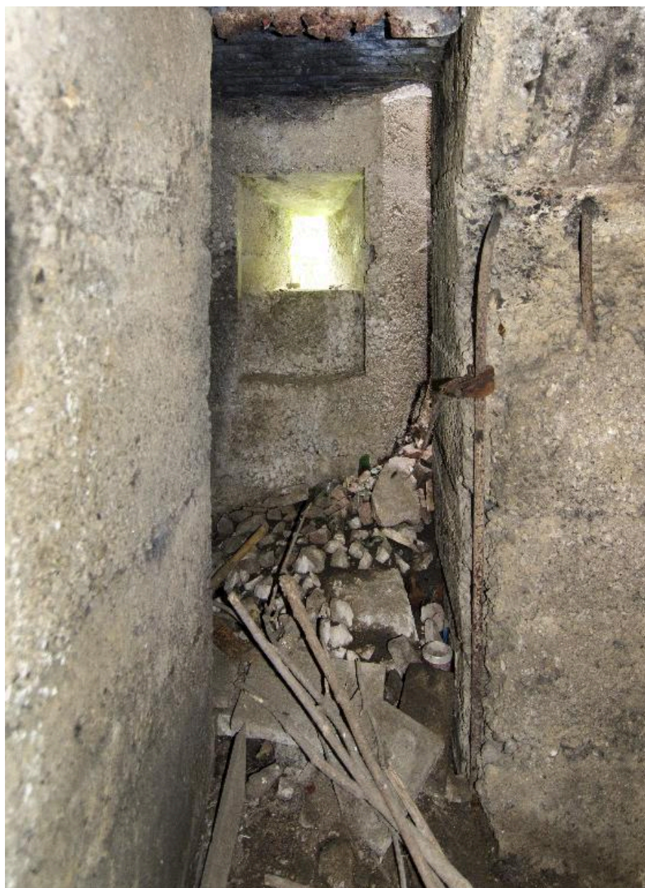
Créneau de fusillade nord
