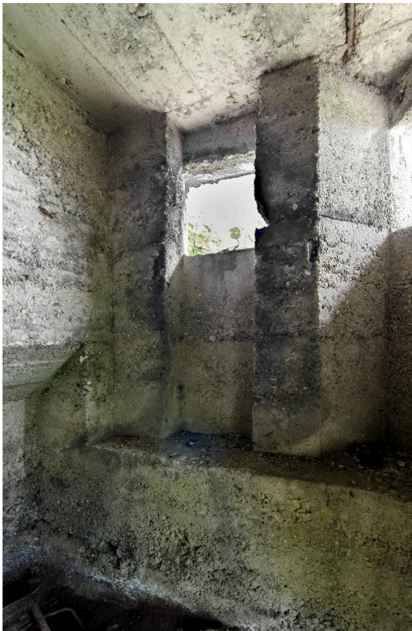
Vue intérieur du poste d'observation
