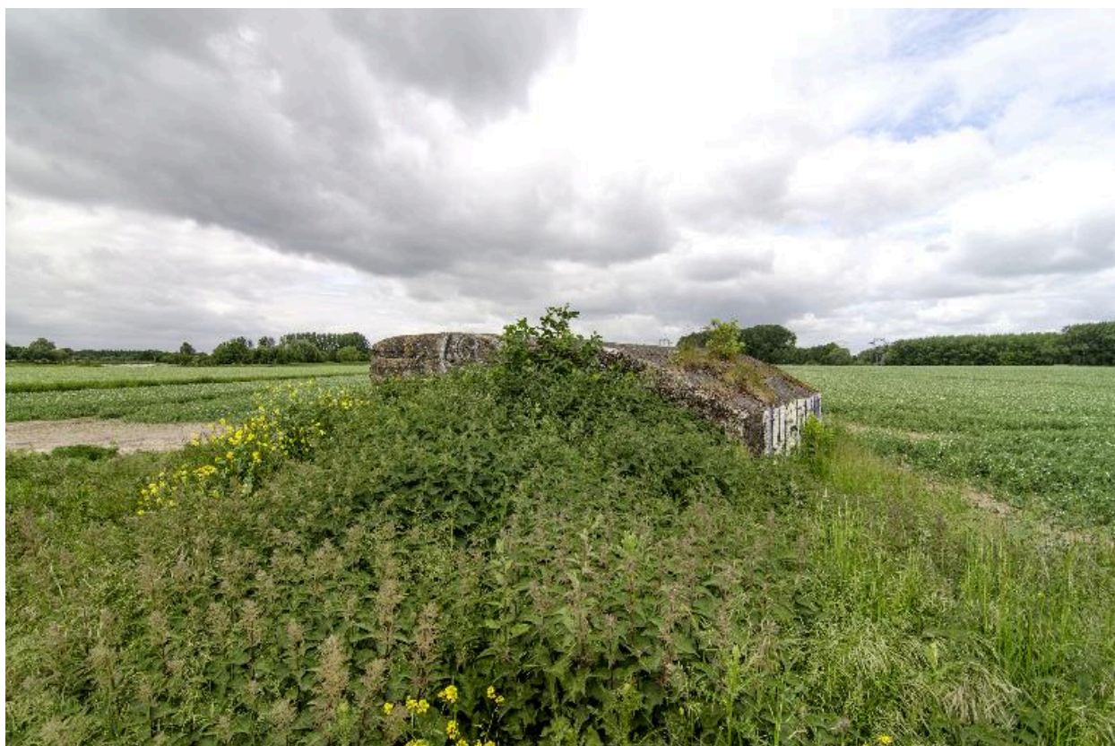
Vue générale vers le nord-est
